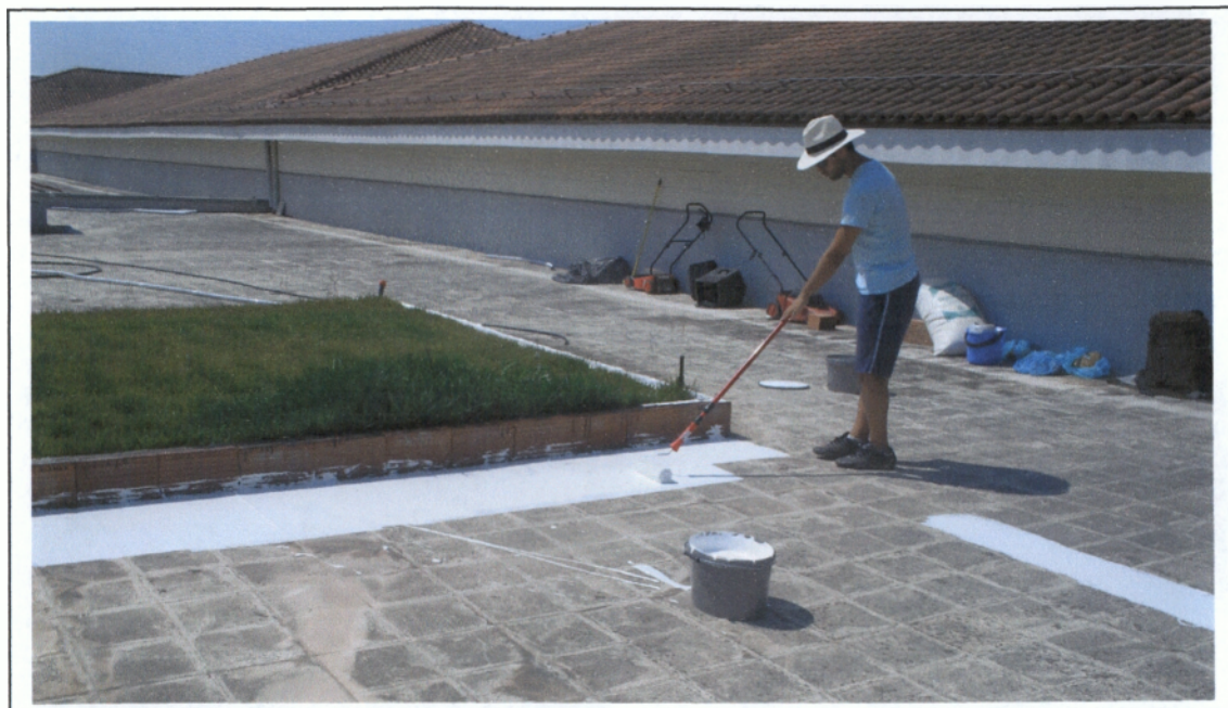
Εικ. 4.1. επικάλυψη του δώματος με ελαστομερές ανακλαστική βαφή βασισμένη στη νανοτεχνολογία. (ταρατσόκηπος ΑΤΕΙ Καλαμάτας ,2008)
