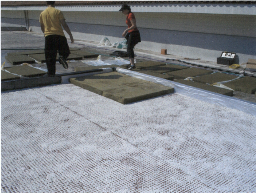
εικ 4.6. δημιουργία στρώσης φύτευσης με πετροβάμβακα. (ταρατσόκηπος ΑΤΕΙ Καλαμάτας, 2007)
