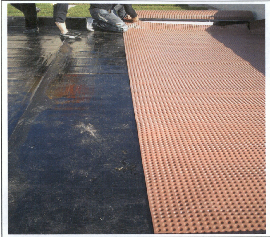
Εικ 4.3. φύλλα πολυπροπυλενίου, εφαρμόζονται πάνω από τη μόνωση. (ταρατσόκηπος ΑΤΕΙ Καλαμάτας, 2007)
