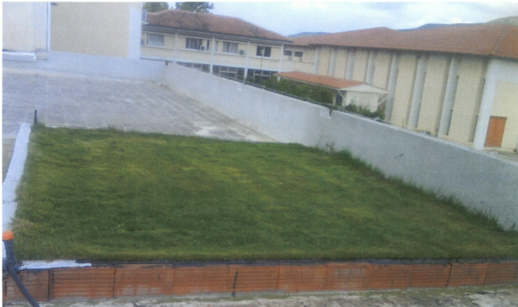
Εικ. 4.8. ολοκλήρωση ταρατσόκηπου του Τ.Ε.Ι. Καλαμάτας. (ταρατσόκηπος ΑΤΕΙ Καλαμάτας, 2007)
