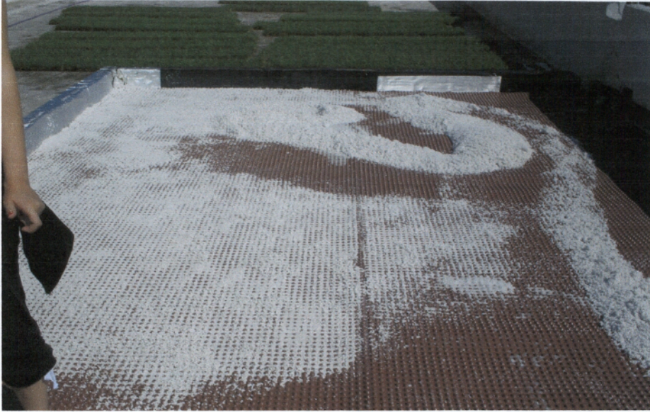
Εικ. 4.5. χρήση περλίτη σε υπόστρωμα ταρατσόκηπου. (ταρατσόκηπος ΑΤΕΙ Καλαμάτας, 2007)
