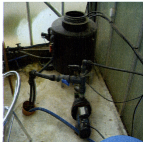
Εικόνα 5 Δεξαμενή συλλογής θρεπτικού διαλύματος (ανακύκλωσης)
