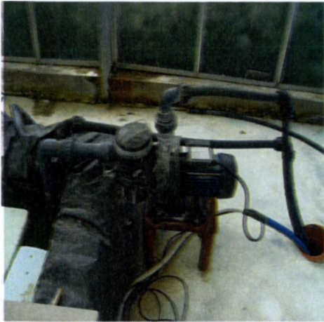
Εικόνα 8 Αντλία εκκένωσης της δεξαμενής επίπλευσης
