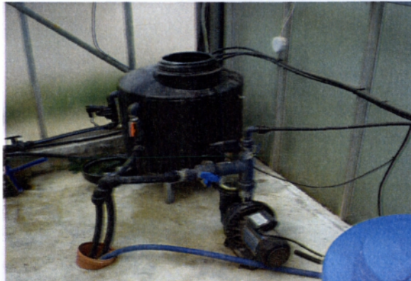
Εικόνα 5: Δεξαμενή συλλογής θρεπτικού διαλύματος
