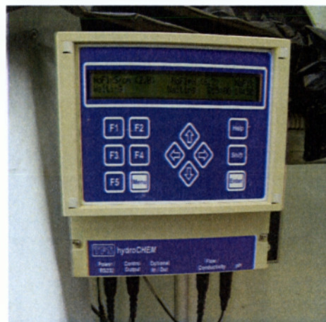
Εικόνα 6 Κεφαλή συστήματος επίπλευσης
