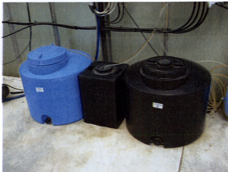
Εικόνα 5: Δεξαμενή συλλογής θρεπτικού διαλύματος
