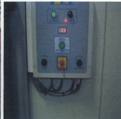
Εικόνα 4: Πίνακας ελέγχου ψυγείων
