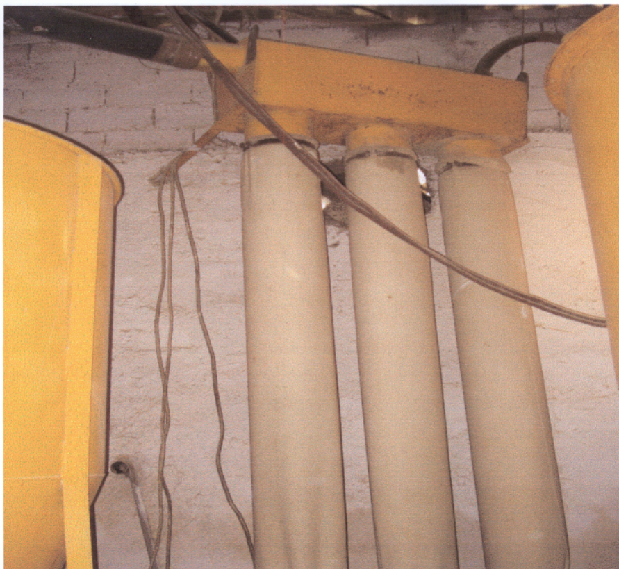
Εικόνα 6.14 Απορροφητήρας σκόνης Χοιροτροφικής Μονάδας Καρύγιαννη Νικόλαου
