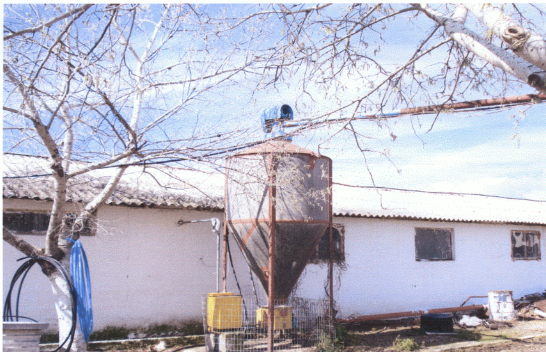
Εικόνα 6.10 Σιλό Πάχυνσης 4 τόνων Χοιροτροφικής Μονάδας Καρύγιαννη Νικόλαου
