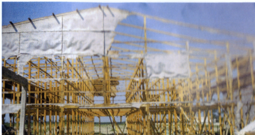
Εικ.3.26. Ξηραντήριο Burley υπό κατασκευή(Καπνός 2000 )
