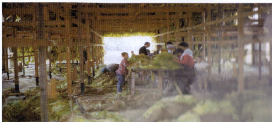
Εικ.3.27. Εσωτερική άποψη Ξηραντηρίου Burley(Καπνός 2000 )
