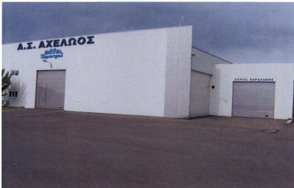
Εικόνα . 2: Οι σύγχρονες εγκαταστάσεις του Συνεταιρισμού στο Δήμο Νεάπολης
