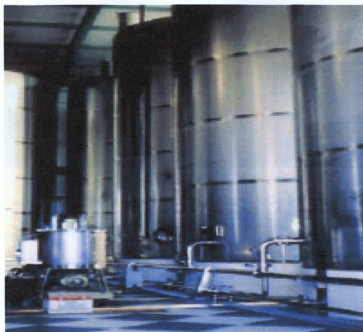
Εικόνα 24.- Δεξαμενές ελαιολάδου σε αποθήκες
