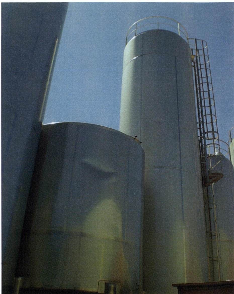
6. Σιλό αποθήκευσης πρώτων υλών
