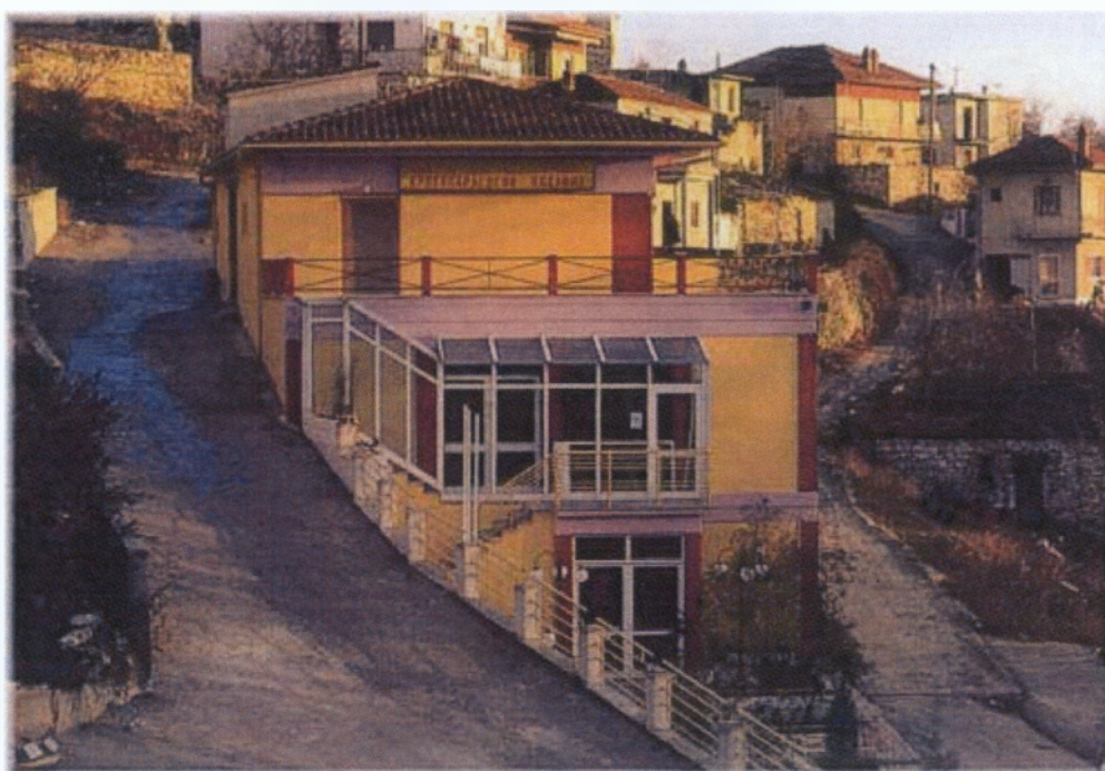
Εικόνα 22: Πρόσψη κτιρίου που στεγάζεται ο Αγροτικός Συνεταιρισμός Κροκοπαραγωγών Κοζάνης.
