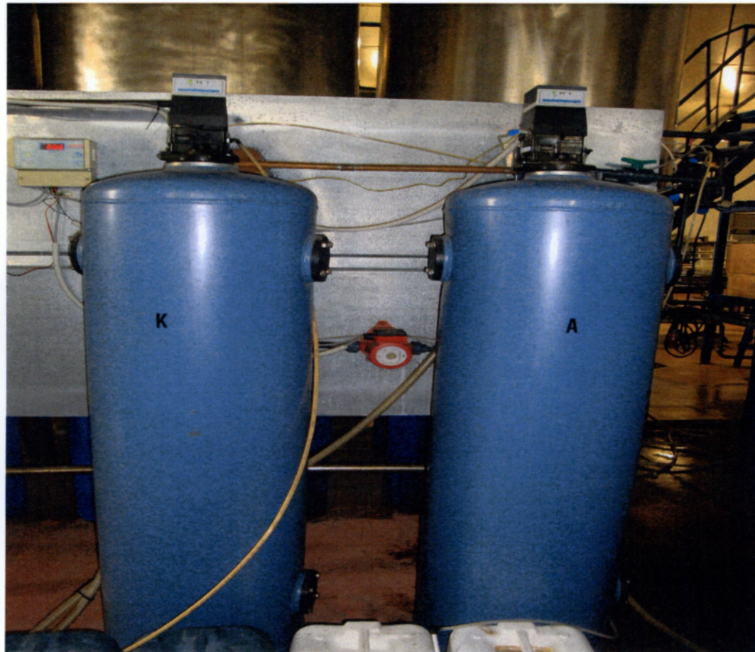
Εικόνα 9. Απιονιστής Πηγή: Καλλικούνης (2009)
