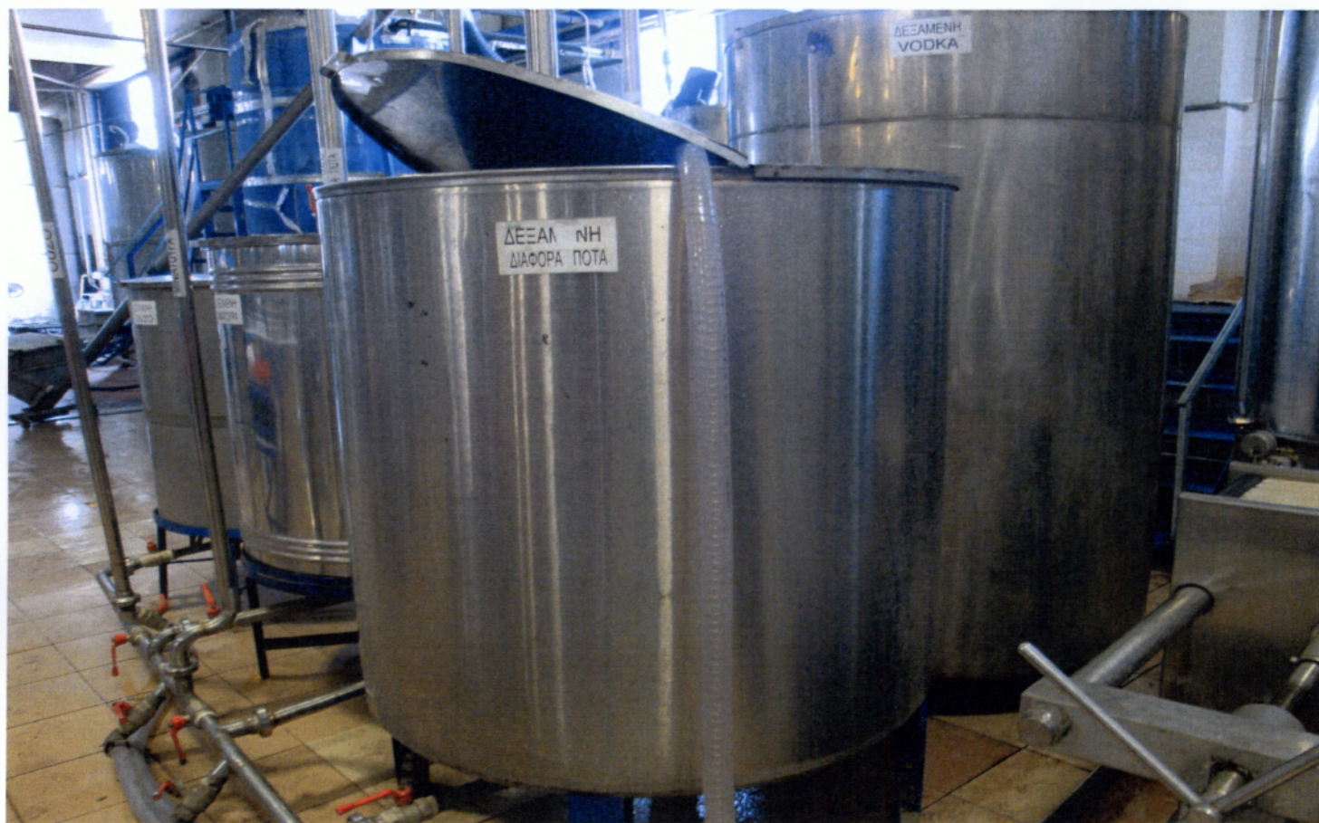
Εικόνα 6. Δεξαμενή αποθήκευσης Πηγή: Καλλικούνης (2009)
