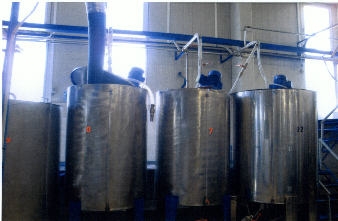
Εικόνα 5. Δεξαμενές ανάμιξης Πηγή: Καλλικούνης (2009)
