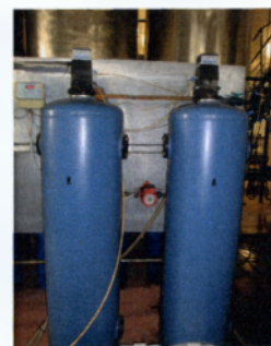
Εικόνα 4. Απιονιστής Πηγή: Καλλικούνης, 2009
