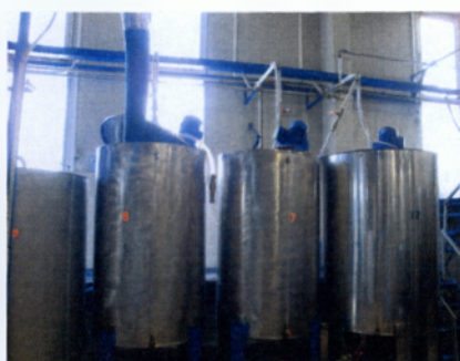
Εικόνα 1. Δεξαμενές ανάμιξης Πηγή: Καλλικούνης, 2009
