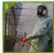
Προστασία κατά τη διάρκεια της εφαρμογής
