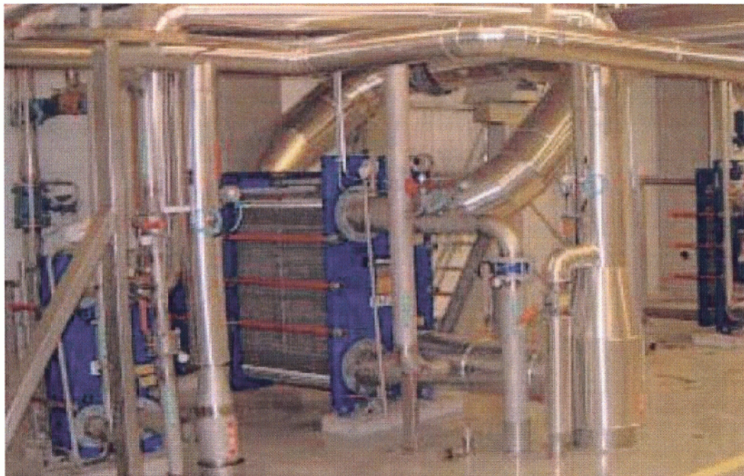
να 3.2: Πλακοειδείς εναλλάκτες θερμότητας σε λειτουργία
