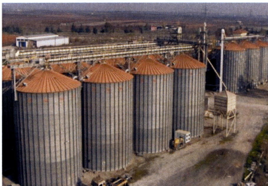
Εικ. 5.1 Αποθηκευτικοί χώροι - σιλό
