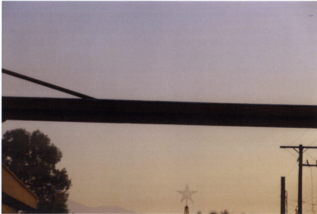
Εικόνα 4. Εναέριες σωλήνες για την μεταφορά λαδιού
