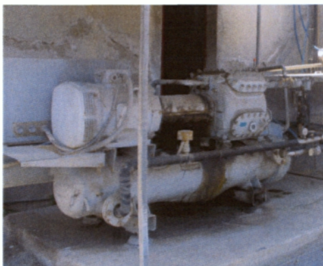
Εικόνα 41: Ψυκτικό μηχανήμα ή τσίλερ (προσωπική λήψη).
