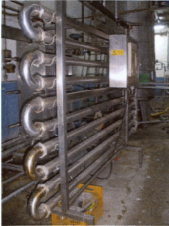
Εικόνα 20: Εναλλάκτης θερμότητας (προσωπική λήψη).
