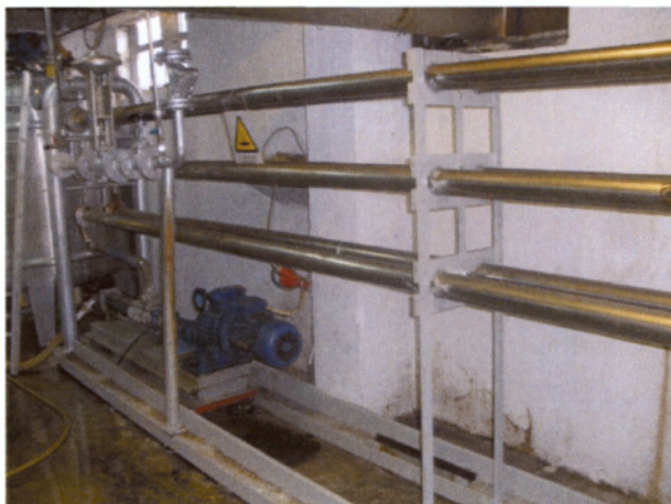
Εικόνα 16: Εναλλάκτης θερμότητας (προσωπική λήψη).
