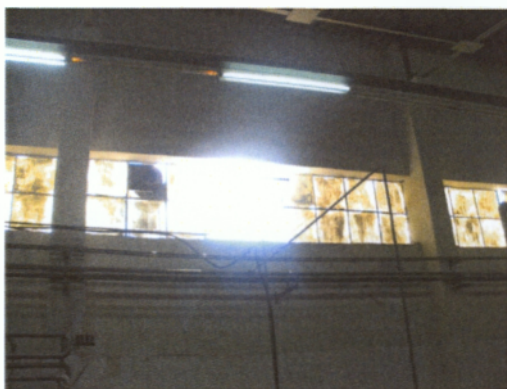
Εικόνα 57: Παράθυρο με εσοχή εσωτερικά του τοίχου (προσωπική λήψη).
