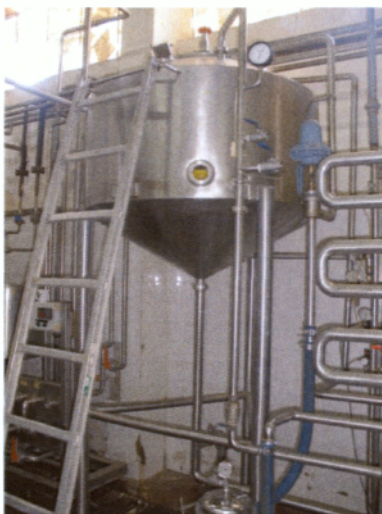
Εικόνα 28: Απαερωτήρας (προσωπική λήψη).
