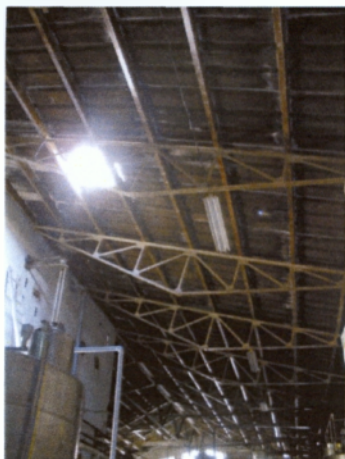
Εικόνα 55: Οροφή εργοστασίου από ελλενίτ (προσωπική λήψη).
