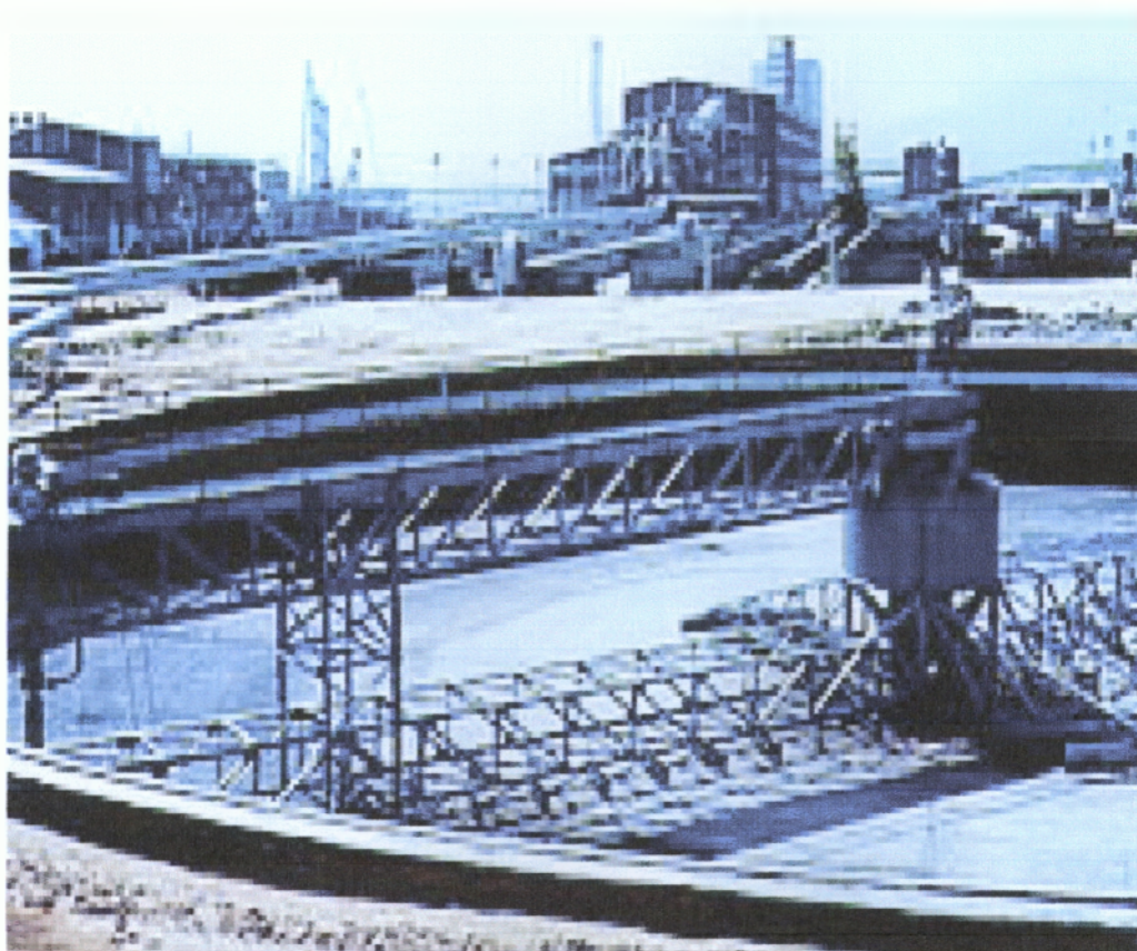
Εικ.26 Ταινία μεταφοράς υγρών αποβλήτων για ανακύκλωση
