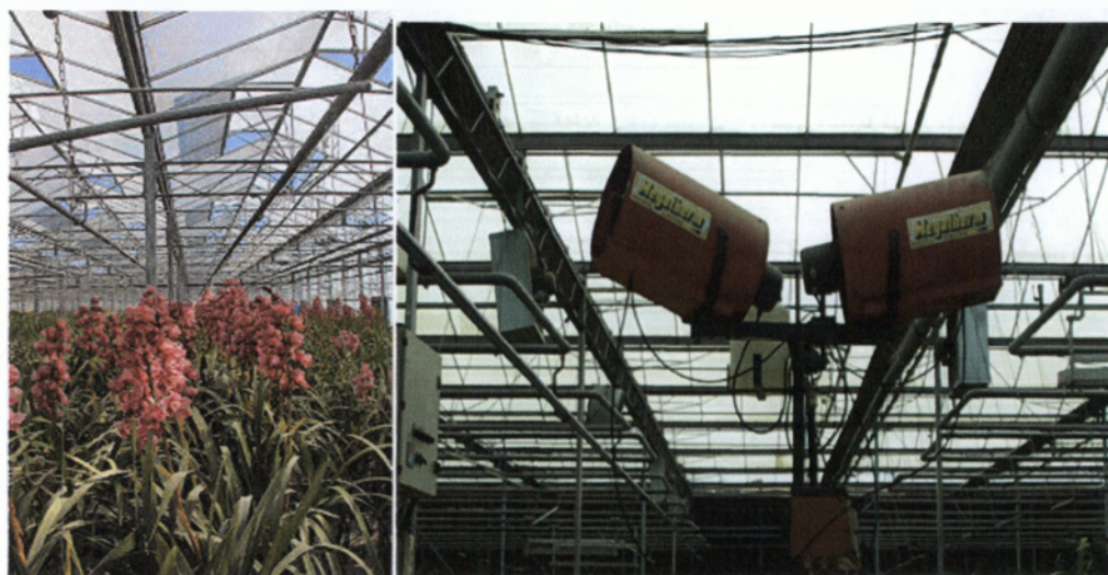
Εικόνα 3.8 Σύστημα ελέγχου ατμοσφαιρικής υγρασίας
