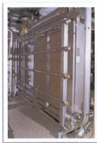
Εικόνα 3.2 Πλακοειδής εναλλάκτης θερμότητας για διεργασίες παστερίωσης βιομηχανικής κλίμακας
