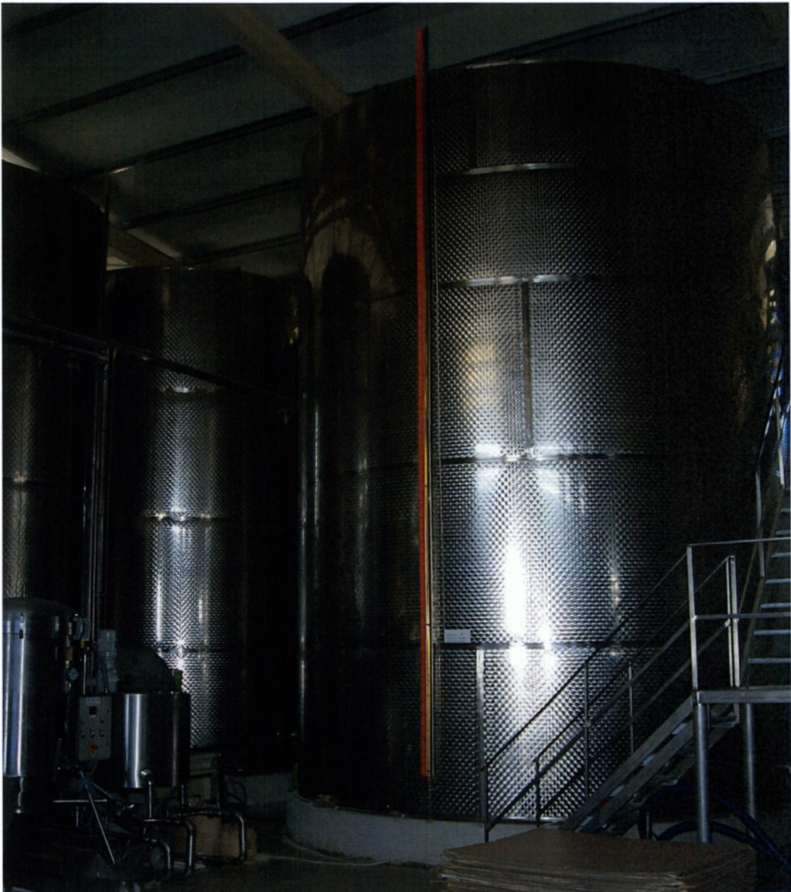
Εικόνα 1. Φίλτρο και δεξαμενές αποθήκευσης ελαιολάδου
