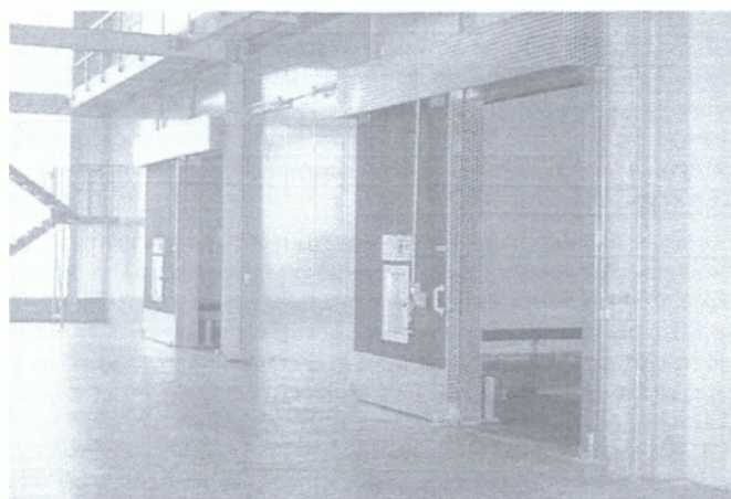
Εικόνα 27 : Θάλαμοι ελεγχόμενης ατμόσφαιρας με ειδικές πόρτες που εξασφαλίζουν στεγανότητα. (Πηγή: Σφακιωτάκης, 2004)
