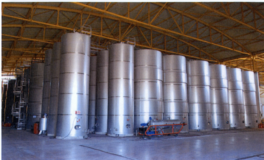
Εικόνα 5.2: Οινοδεξαμενές αποθήκευσης κρασιού «ΝΕΣΤΩΡ»
