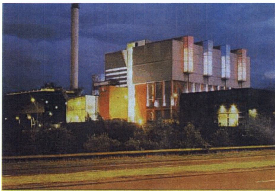
3.4 (Εργοστάσιο καύσης απορριμμάτων)
