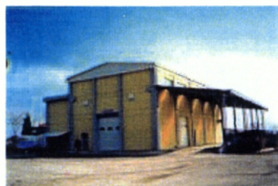
Εικόνα 7. Κτίριο ελέγχου φορτηγών
