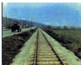
Εικόνα 10. Μετά την ανακαίνιση
