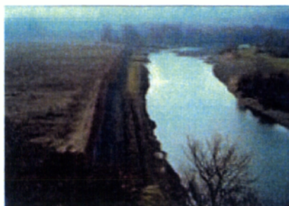
Εικόνα 3. Ο ποταμός Άρδας μετά την κατασκευή του φράγματος
