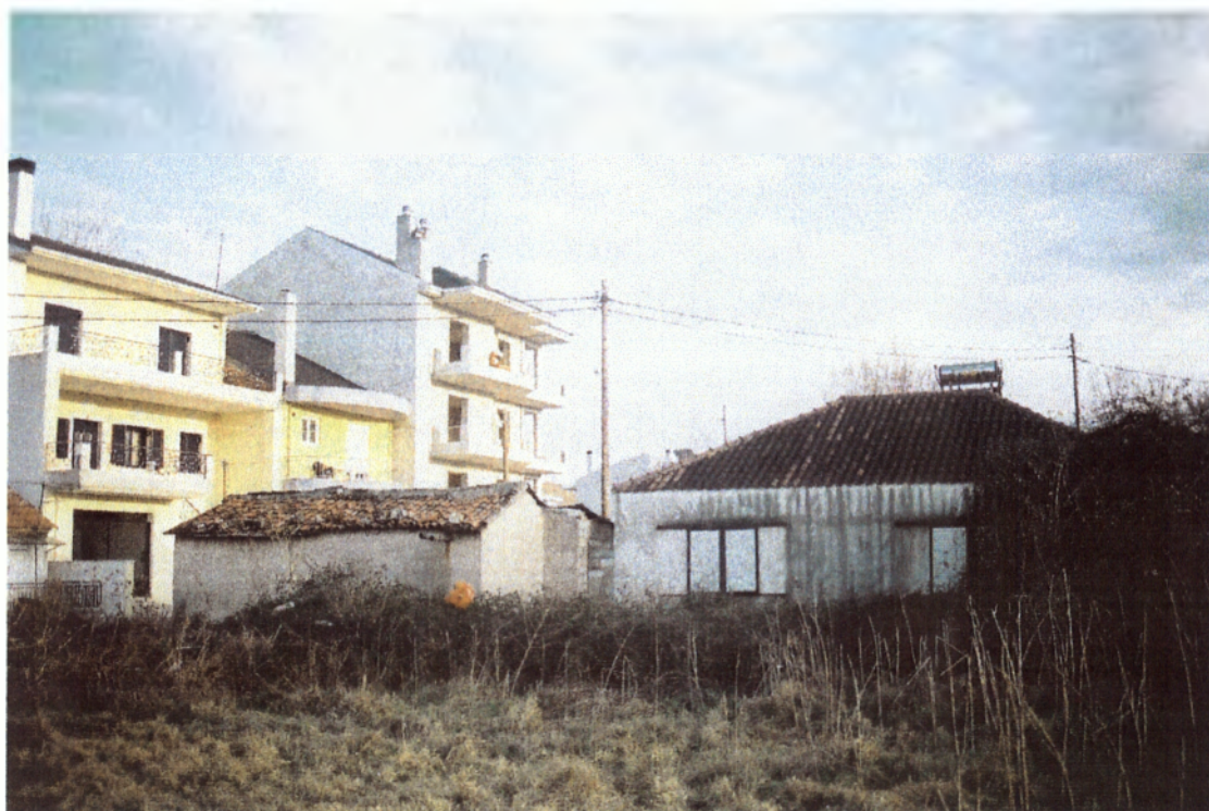
ΦΩΤ.3 ΠΕΡΙΟΧΗ ΛΑΣΠΟΤΟΠΟΥ (ΑΚΑΝΟΝΙΣΤΗ ΚΑΙ ΤΥΧΑΙΑ ΚΑΤΑΝΟΜΗ ΠΡΟΫΦΙΣΤΑΜΕΝΩΝ ΚΤΙΣΜΑΤΩΝ)
