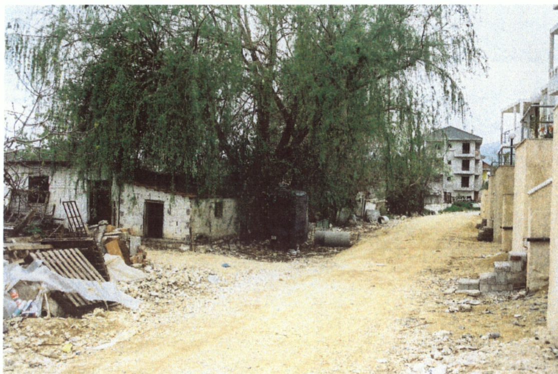
ΦΩΤ. 4 ΠΕΡΙΟΧΗ ΛΑΣΠΟΤΟΠΟΥ (ΑΚΑΝΟΝΙΣΤΗ ΚΑΙ ΤΥΧΑΙΑ ΚΑΤΑΝΟΜΗ ΠΡΟΫΦΙΣΤΑΜΕΝΩΝ ΚΤΙΣΜΑΤΩΝ)
