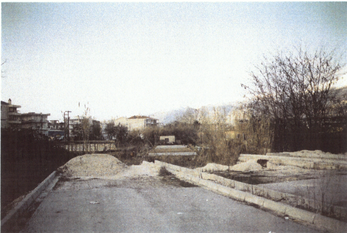
ΦΩΤ. 6 ΛΕΩΦΟΡΟΣ ΓΕΝΝΗΜΑΤΑ (ΚΑΤΑΣΚΕΥΑΣΜΕΝΟ ΤΜΗΜΑ)
