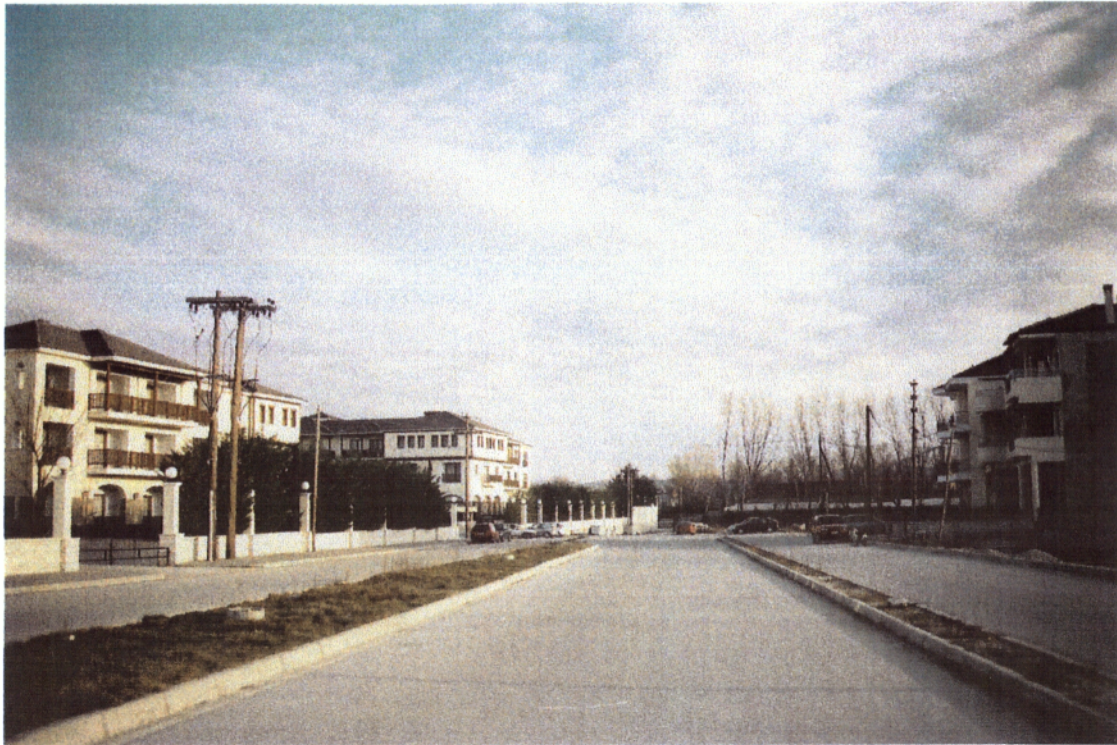
ΦΩΤ. 5 ΛΕΩΦΟΡΟΣ ΓΕΝΝΗΜΑΤΑ (ΚΑΤΑΣΚΕΥΑΣΜΕΝΟ ΤΜΗΜΑ)
