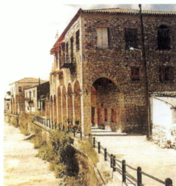
Παραδοσιακό κτίριο στην Θουρία
