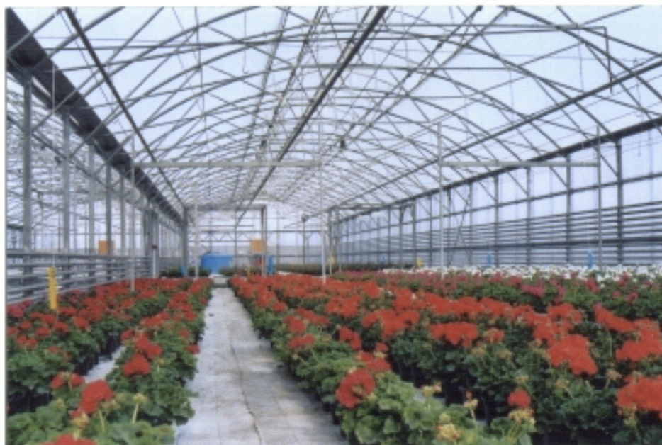
Εικόνα 2: Θερμοκήπιο που λειτουργεί με χρήση τηλεθέρμανσης
