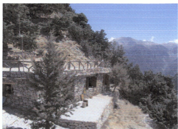
Το Φυλάκιο Ασφαλείας στο Ξυλόσκαλο
