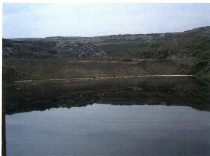
Εικόνα 8.4 : Υδραυλικά δίκτυα διαχείρισης ομβρίων υδάτων και κατασκευή επιφανειακής λίμνης συγκέντρωσής τους.
