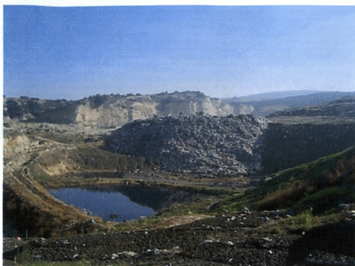
Εικόνα 8.3 : Υδραυλικά δίκτυα διαχείρισης ομβρίων υδάτων και κατασκευή επιφανειακής λίμνης συγκέντρωσής τους.
