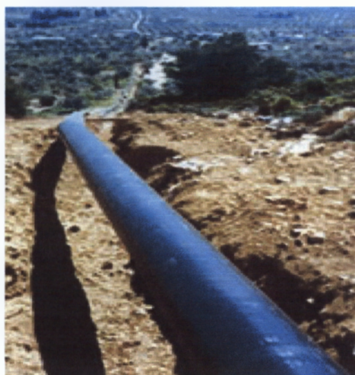
Εικόνα 1. Εργασίες τοποθέτησης σωλήνων
