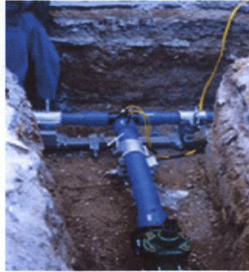
Εικόνα 2. Εργασίες σύνδεσης με νέο δίκτυο
