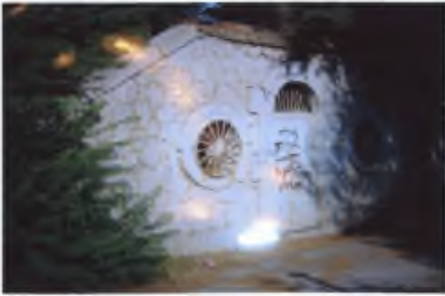
Είσοδος Παλαιάς Δεξαμενής
