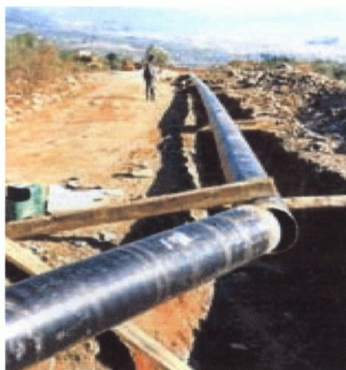
Εικόνα 2. Εργασίες τοποθέτησης σωλήνων
