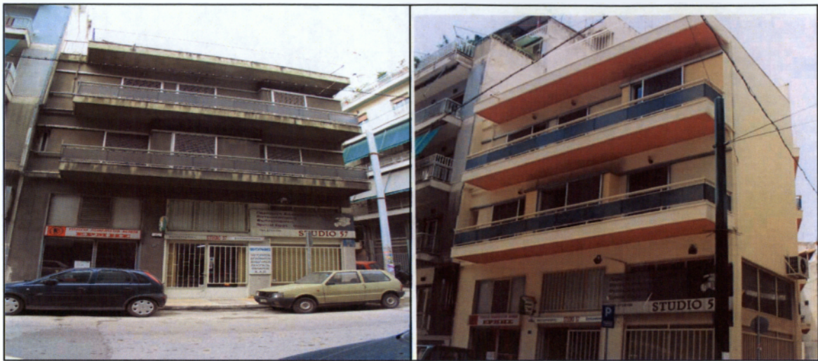
Εικόνα 9 : Ένα κοινό κτίριο στη διασταύρωση Νηλέως και Χλωρίδος
