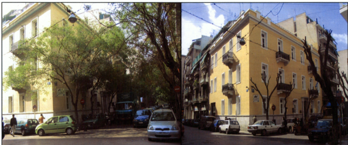
Εικόνα 10 : Το διατηρητέο κτίριο στη διασταύρωση των οδών Φαβιέρου και Μάγιορ, στο οποίο στεγάζεται η Αναπτυξιακή Εταιρεία Δήμου Αθηναίων.
