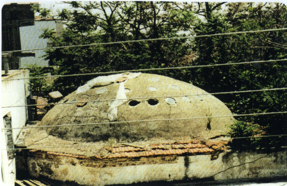
: Εξωτερική όψη του Οθωμανικού λουτρού , Ρυμοτομική Εξέλιξη - Αξιόλογα Κτίρια , Αναπτυξιακή Κιλκίς Α.Ε. , Κιλκίς 1995 ,σελ 141
