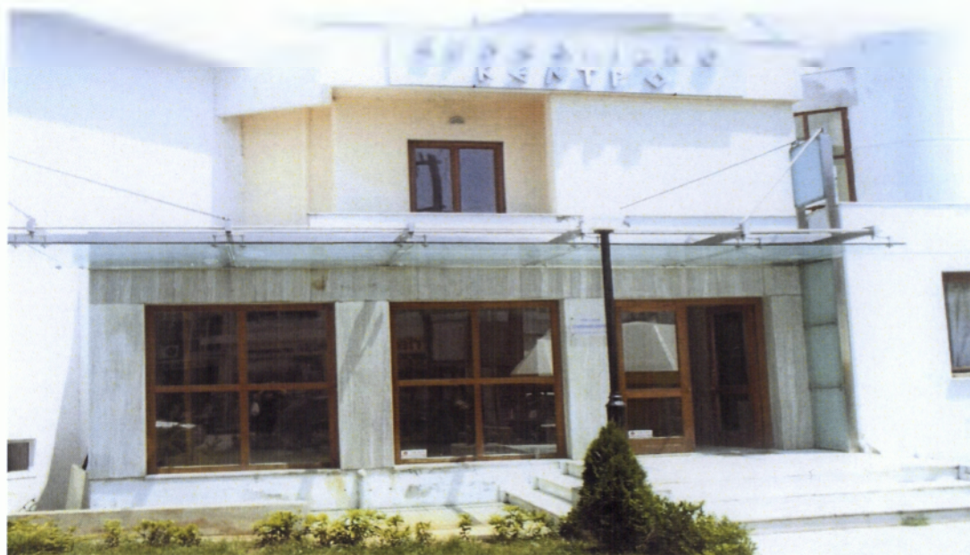
: Συνεδριακό κέντρο Δήμου Κιλκίς ,Εξωτερικός χώρος , 2007
