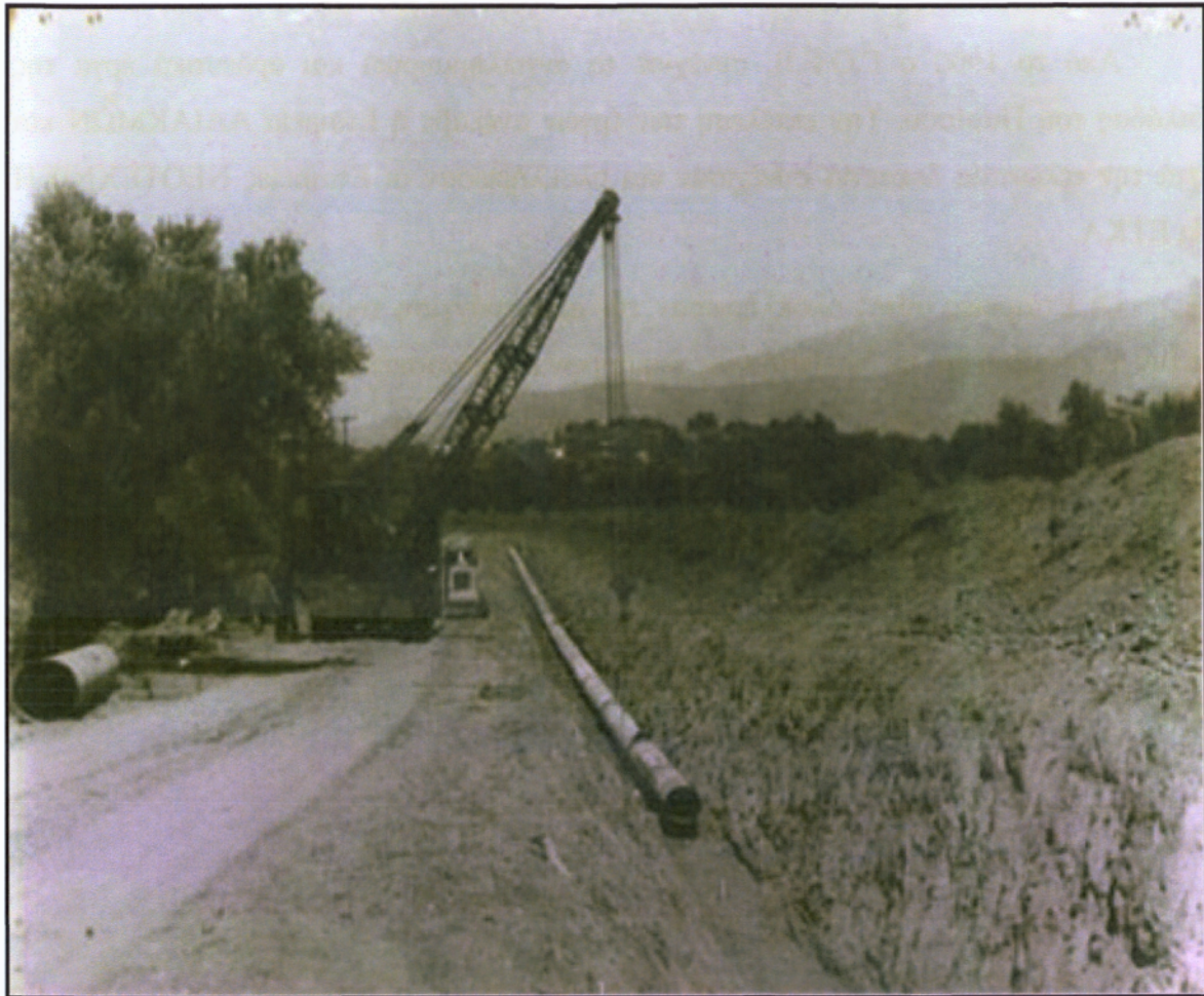
Κατασκευή αρδευτικού δικτύου την δεκαετία του '60
