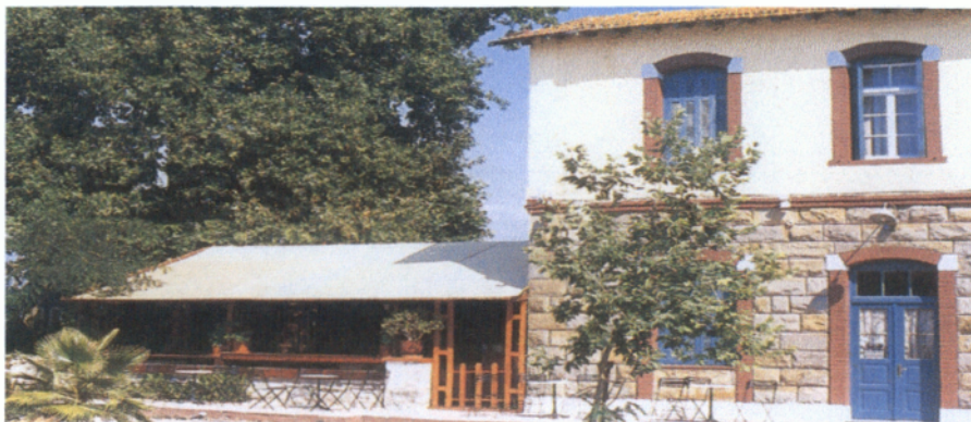
(Ο σταθμός ΟΣΕ στην πόλη της Μεσσηνίας)
