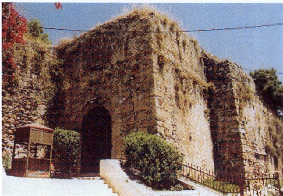
Φωτ. 4.9 Είσοδος Κάστρου πριν την ανάπλαση Πηγή: ΜΕΣΣΗΝΙΑΣ περιήγησις (βλ. βιβλιογραφία)
