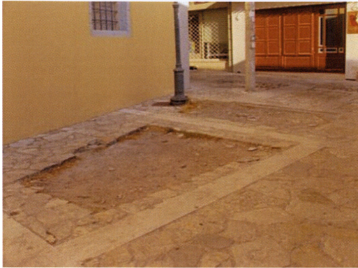
Φωτ.7.5 Αποξήλωση πλακών Πηγή: προσωπικό αρχείο
