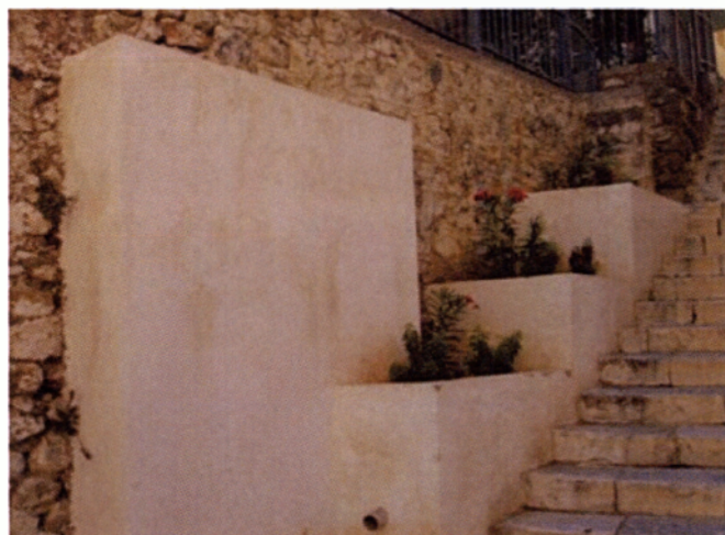
Φωτ.4.8 Κλίμακα μετά την ανάπλαση (κάλυψη καλωδίων)
