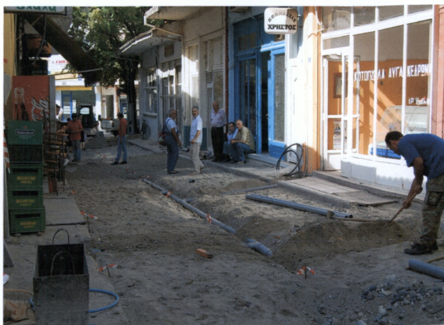
Φωτ 2.16 Τοποθέτηση σωλήνα για την διέλευση των καλωδίων. Οδός Παπασοβίνα.
