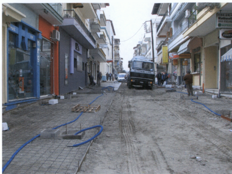
Φωτ. 2.18 Τοποθέτηση των καλωδίων των φωτιστικών σωμάτων
