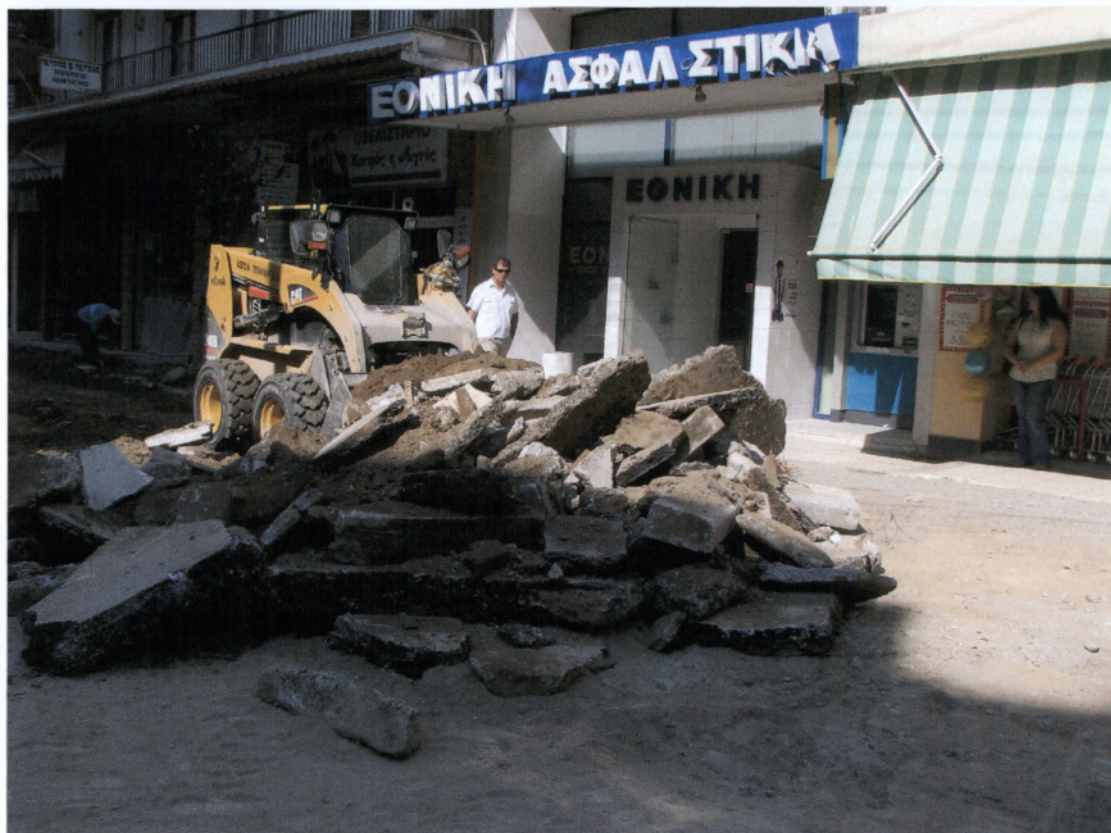
Φωτ. 2.13 Καθαίρεση ασφάλτου και εκσκαφές
