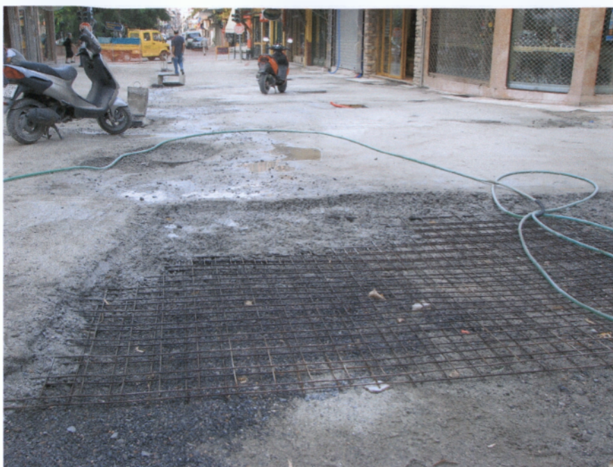
Φωτ. 2.22 Τοποθέτηση πλέγματος βαρέως τύπου στο σκυρόδεμα
