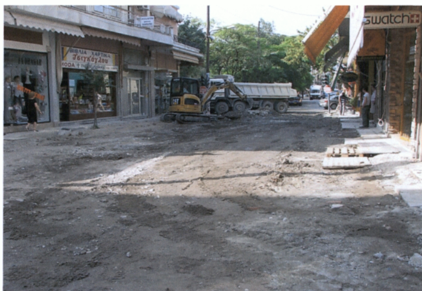
Φωτ. 2.19 Επίχωση πριν την κατασκευή βάσης σκυροδέματος.
