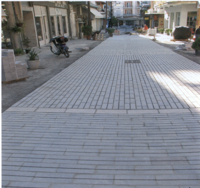
Φωτ. 2.23 Στρώση των κυβόλιθων με κλίση προς τα φρεάτια πάνω στην βάση από οπλισμένο σκυρόδεμα. Οδός Αριστοτέλους
