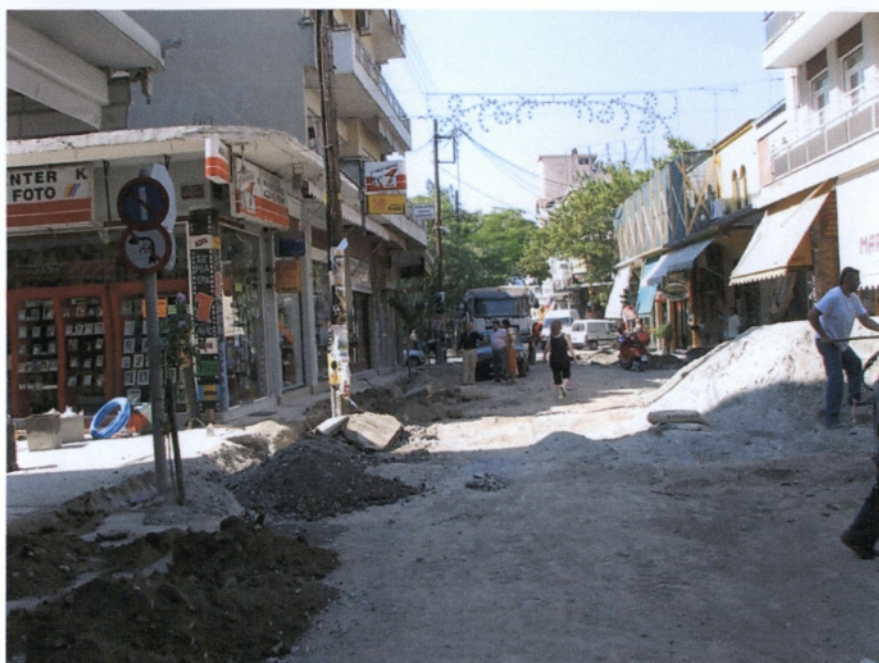
Φωτ. 2.17 Γενική εκσκαφή κατά 30 περίπου cm. Οδός Δημοκρατίας.
