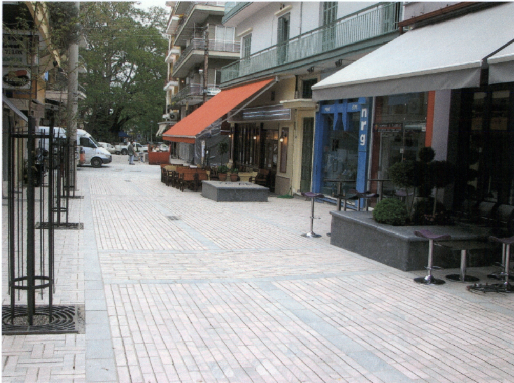
Φωτ. 2.25 Τελική όψη δρόμων Οδός Ηρώων Πολυτεχνείου
