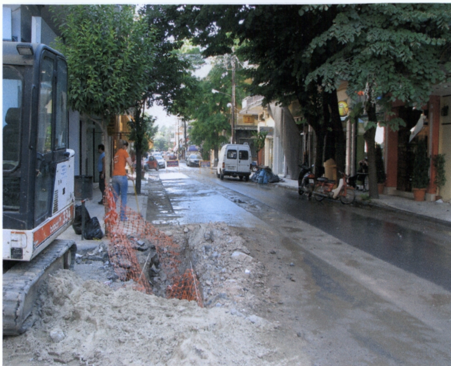
Φωτ. 2.14 Εκσκαφές για την τοποθέτηση της ύδρευσης και της αποχέτευσης πριν την έναρξη των εργασιών
