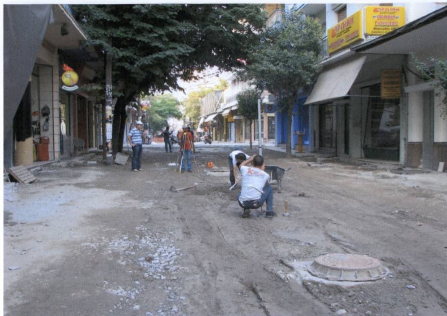
Φωτ. 2.15 Κατασκευή κεντρικών φρεατίων για την συλλογή των ομβριων υδάτων.
