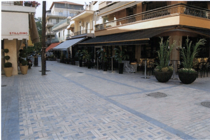
Φωτ 2.29 Ο πεζόδρομος μετά το πέρας των εργασιών, οδός Ηρώων Πολυτεχνείου.
