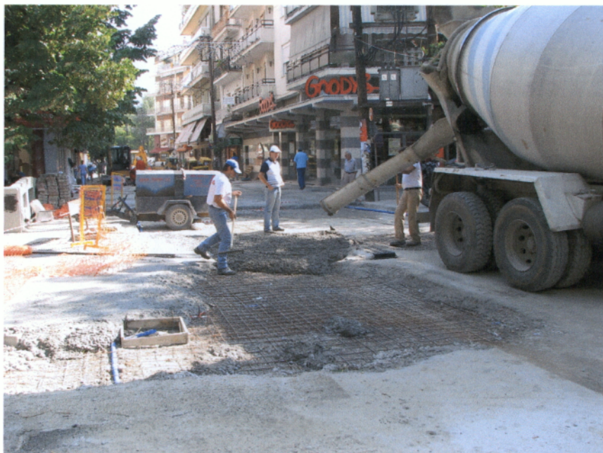
Φωτ. 2.21 Κατασκευή βάσης οπλισμένου σκυροδέματος
