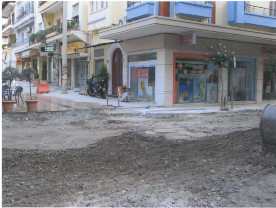
Φωτ. 2.20 Διαβροχή και συμπύκνωση της επίχωσης. Οδός Δημοκρατίας.
