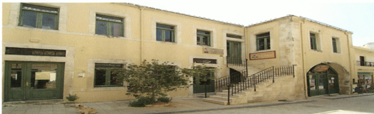
Κτίριο 'Γραφείων Κοινωνικών Υποστηρικτικών Υπηρεσιών' στο Δήμο Αρχανών.
