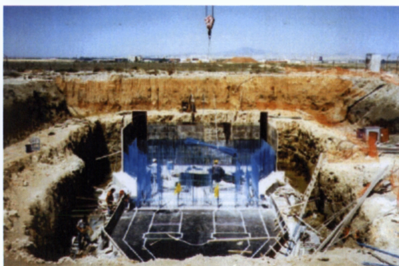
1. Κατασκευή αντλιοστασίου θαλάσσιου νερού
