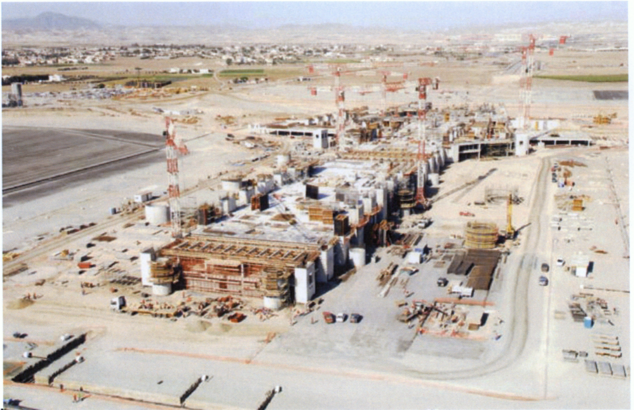
ΝΕΟ ΑΕΡΟΔΡΟΜΙΟ ΛΑΡΝΑΚΑΣ – ΚΑΤΑΣΚΕΥΑΣΤΙΚΕΣ ΕΡΓΑΣΙΕΣ
