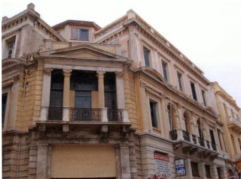
Εικόνα 24: Κτίριο επί των οδών 25 ης Αυγούστου και Επιμενίδου
