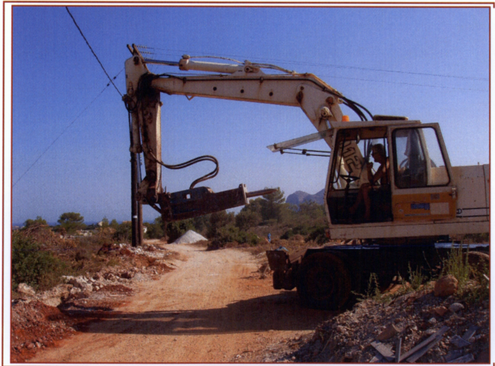
Αγωγός Φ90 Καμπάνι
