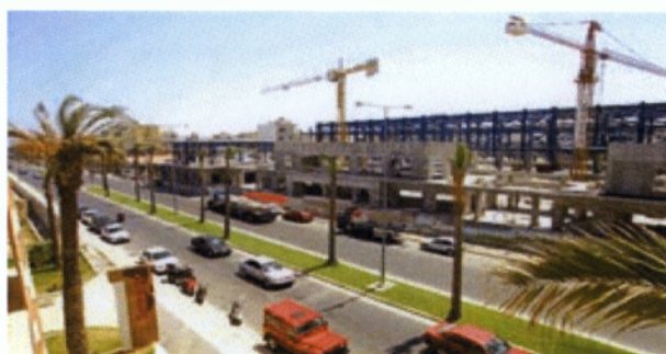
Εικόνα 4.2: Στιγμιότυπο από τη κατασκευή του "Talos Plaza"
