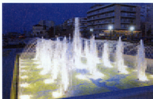
Εικόνα 3.4: Υδάτινη εγκατάσταση πλατείας Ξενία
