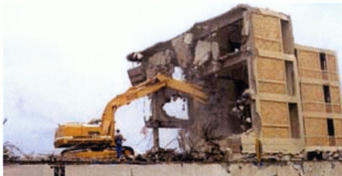
Εικόνα 3.2: Ξενοδοχείο Ξενία κατά την κατεδάφιση
