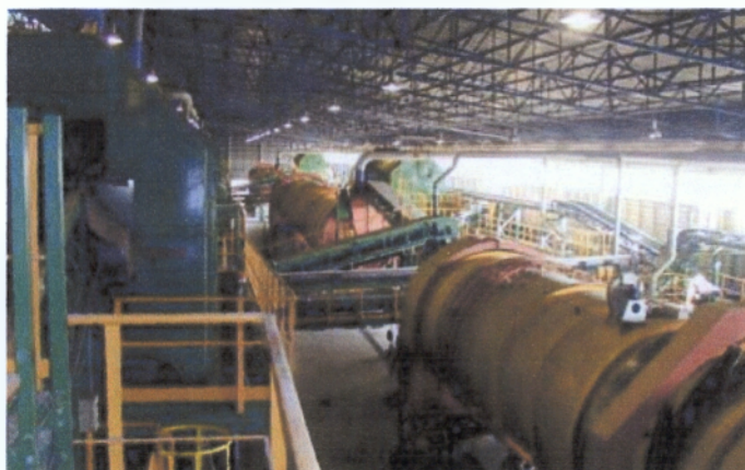
Εικόνα 3.1: Εργοστάσιο Μηχανικής Ανακύκλωσης και Κομποστοποίησης στα Άνω Λιόσια
