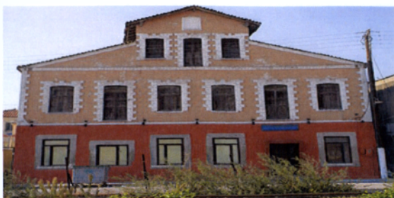
Παραδοσιακό κτίριο δίπλα στην σιδηροδρομική γραμμή
