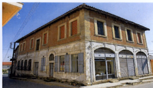
Κτίριο προς ανακαίνιση σε κεντρικό δρόμο του Σουφλίου
