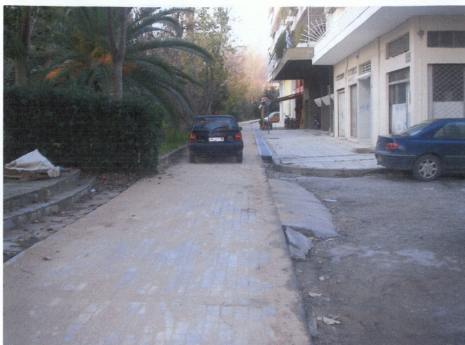
Φωτογραφία 2.13 Οδός Αριστομένους με καλυμμένα φρεάτια μετά την κατασκευή του ποδηλατοδρόμου
