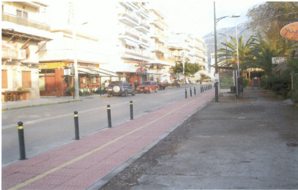
Φωτογραφία 2.8 Στάση λεωφορείων επί της οδό Ναυαρίνου δίχως τις αρχικά προβλεπόμενες ορθογώνιες εσοχές στην επέκταση του πεζοδρομίου για την απορροή των ομβρίων.
