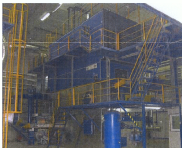
Εικόνα 15: Εστία καύσης και λέβητας ατμού μονάδος καύσης πτηνάλευρου (ΠΗΓΗ : www. images.google.gr )
