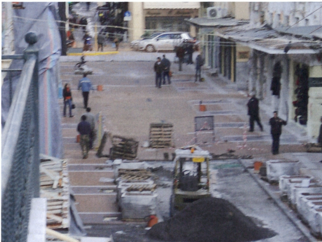
Εικόνα 3.6: Κάλυψη με έγχρωμους κιβόλιθους
