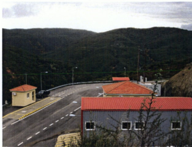
Εικόνα 3.12 Άλλες εγκαταστάσεις του Χ.Υ.Τ.Α. στη Βλαχομάνδρα
