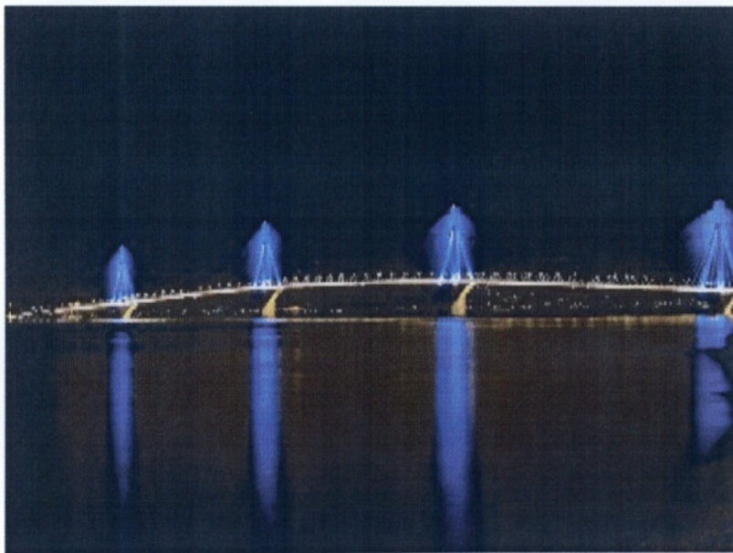
Η γέφυρα Ρίου – Αντιρίου
