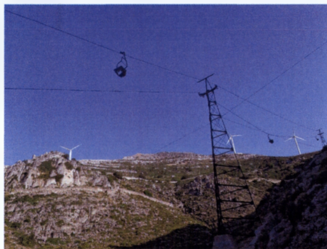
Εικόνα 5: Οι εγκαταστάσεις του εναέριου για τη μεταφορά του σφυριγλιού
