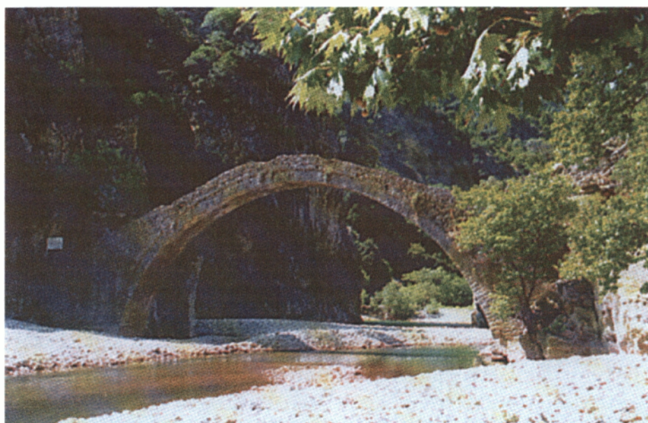
Το παλιό μεσαιωνικό γεφύρι στο Εύηνο, κοντά στο "Βλατσόρεμα"
