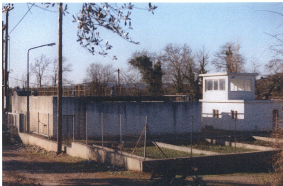
Μονάδα Βιολογικού καθαρισμού στο Θέρμο
