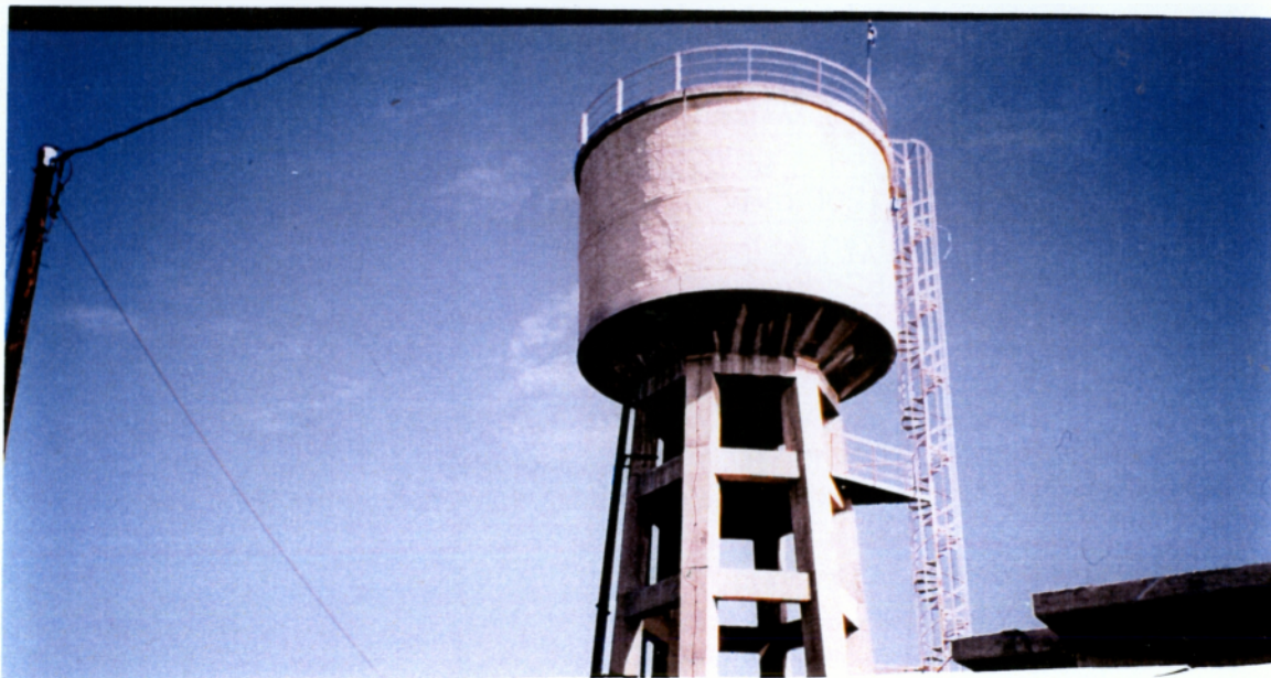
Εικ.1 «Υδατόπυργος Μεσσήνης έτος κατασκευής 1995»
